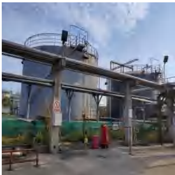
有机原料罐区（老罐区）
